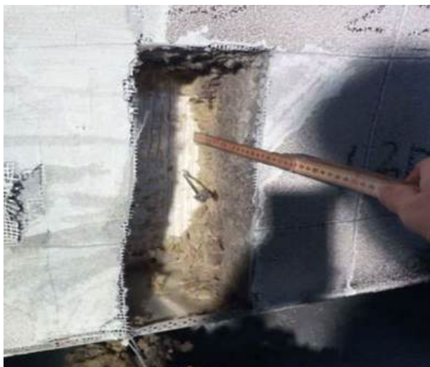
TEST - SISTEMI ETICS CON ISOLANTI INCOMBUSTIBILI
