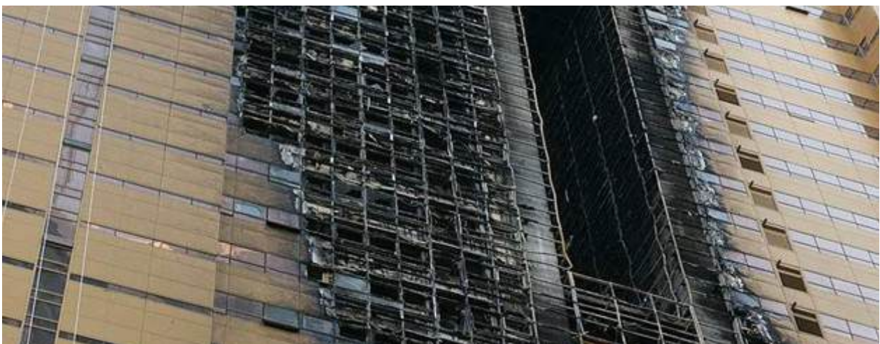
DIFFUSIONE DELL'INCENDIO ALL'INTERNO DI CAVITÀ VERTICALE INTERNA
