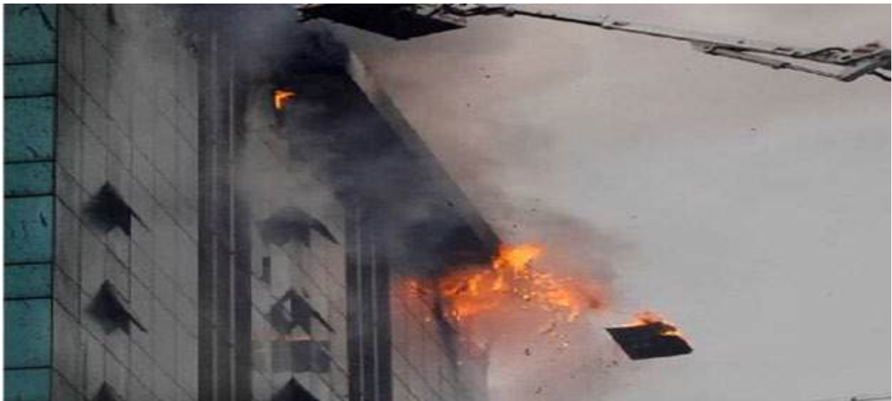
DIFFUSIONE DELL'INCENDIO PROVOCATA DALLA CADUTA DI DETRITI IN FIAMME AI PIANI INFERIORI
