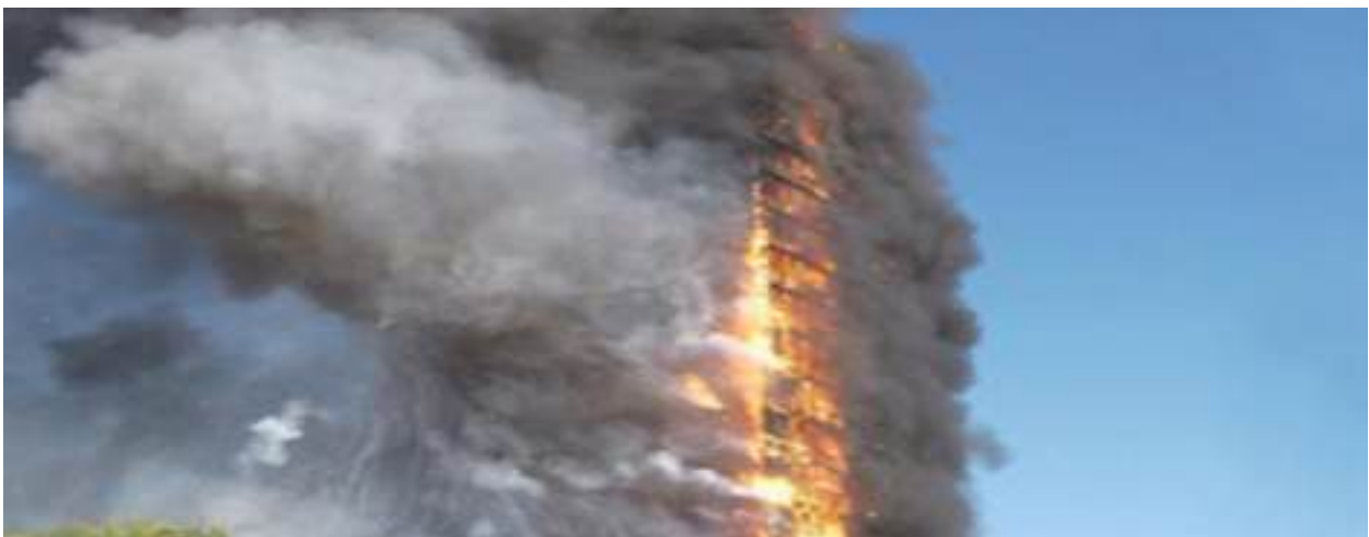
DIFFUSIONE DELL'INCENDIO SULLA SUPERFICIE ESTERNA DELLA PARETE
