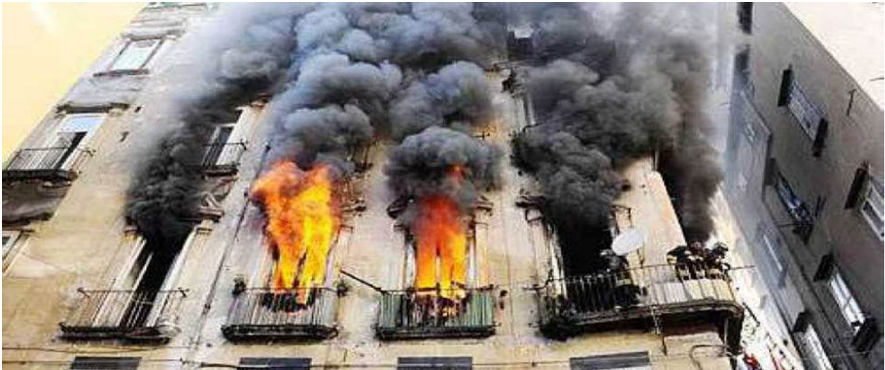
PROPAGAZIONE DELL'INCENDIO SULLA FACCIATA
